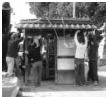
作業風景(門の移設)
