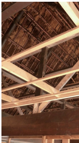
改修中の家は茅葺き屋根の平屋
