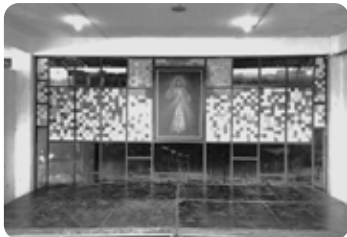
チャペルの竣工 (12/09)
