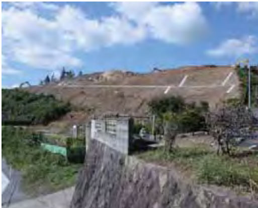
2014 年 9 月 田の浦の高台移転工事の様子
