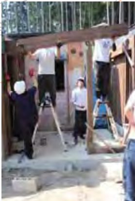
トイレ前の増設工事の様子
