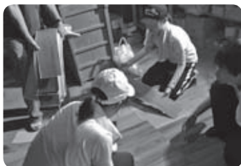
物置の床の改修（08/25）
