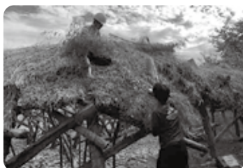
屋根のメンテナンス (09/21)
