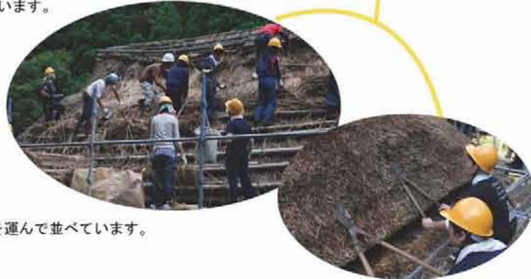
妻面の古い茅を抜いて、新しい茅をさす「さし茅」をしています。
