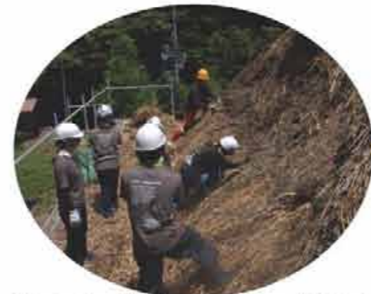
妻面の古い茅を抜いて、新しい茅をさす「さし茅」をしています。
